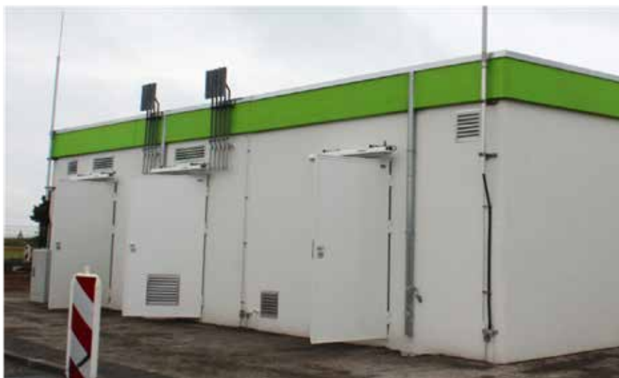
Abb. 7: Wand- en pijpmontage: intern geïnstalleerde isCon ® -afleiding in vangmast op biogasinstallatie
