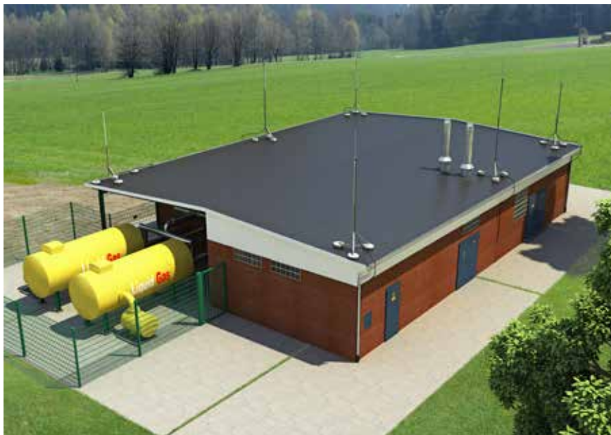
Abb. 6: isCon ® -installatie op opvangsers in Ex-omgeving
